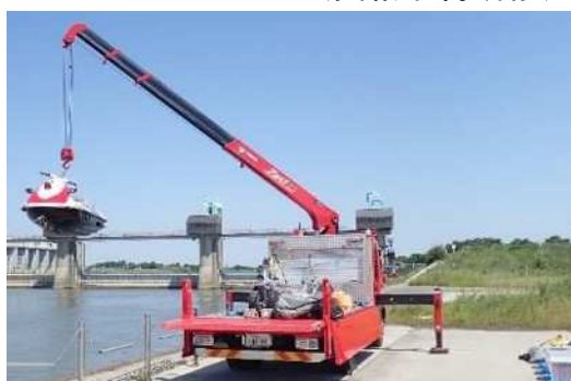
【玉掛・クレーン技能訓練実施状況（資格取得研修）】
